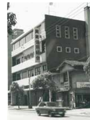
① 本店竣工
